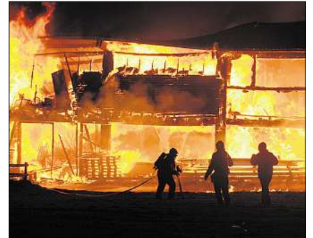
Lagerhalle fiel Flammen zum Opfer.
